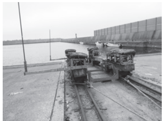
▲千走漁港上架施設
