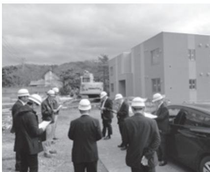
→ 教職員住宅建設現場の視察
