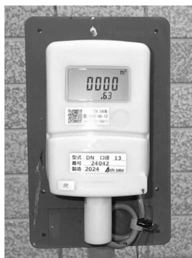
▶ 施行後：スマート水道メーター
