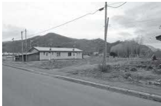
▲除却予定の泊団地
