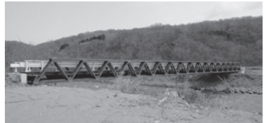
▲ 千走地区 冷水橋仮橋
