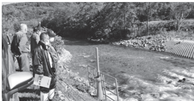
→千走第3頭首工状況視察
