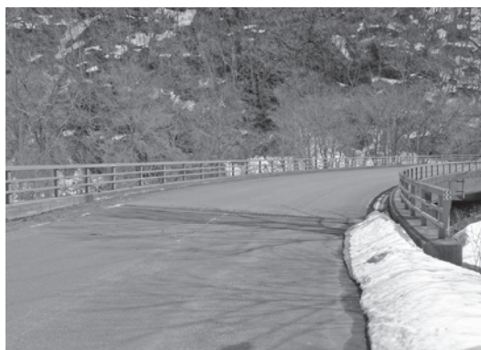
▲補修工事が行われる弁慶橋
