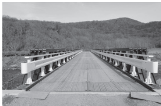
▲ 架替工事が行われている冷水橋
