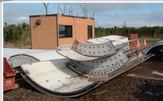
④ 取り外した部位（タワー）の解体（2）
