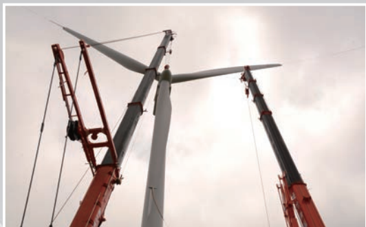
① ブレード（羽根）の取り外し
