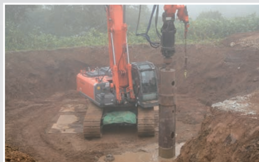
⑤ 基礎杭の周囲を専用機械で掘削
