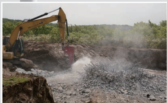
④ 基礎部コンクリートの解体
