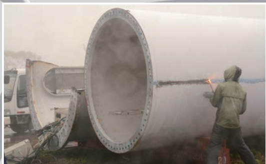
③ 取り外した部位（タワー）の解体（1）
