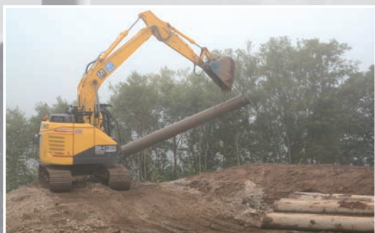
⑥ 基礎杭の引き抜き撤去・搬出
