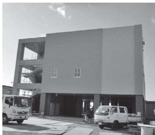
▲建設中の(仮称)小規模多機能型居宅介護施設
