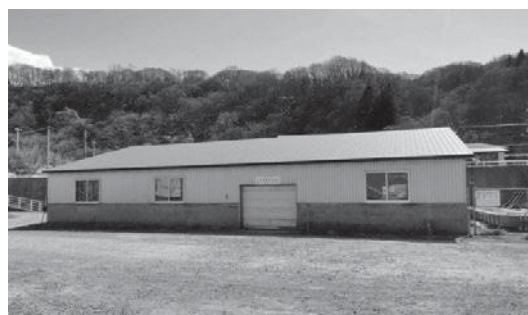
▲千走漁港種苗生産施設
