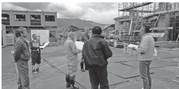
▶ 小規模多機能型居住介護施設建設工事現場で説明を受ける
