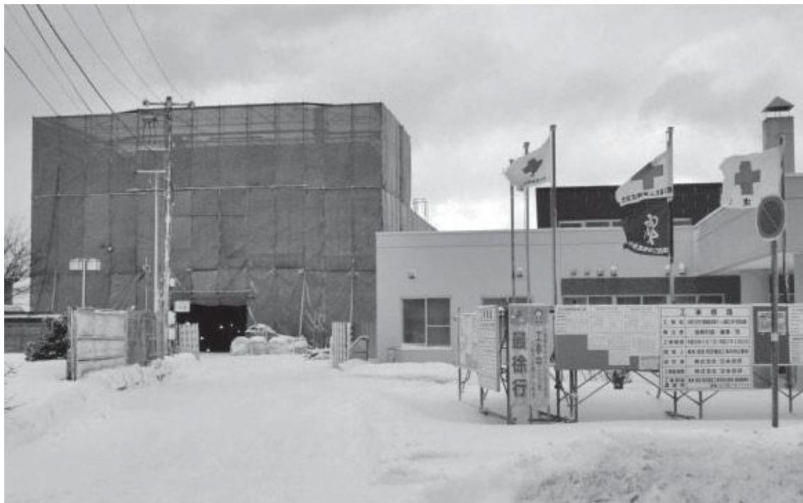
▲現在建設中の小規模多機能型居住介護施設
