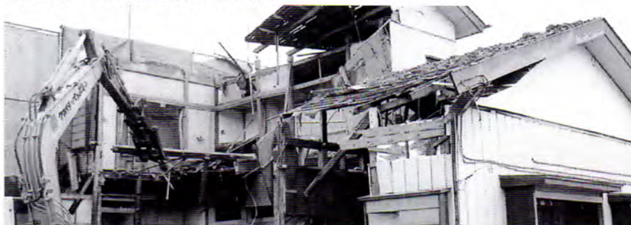
③ 外装材・上部構造部分の取り壊し
