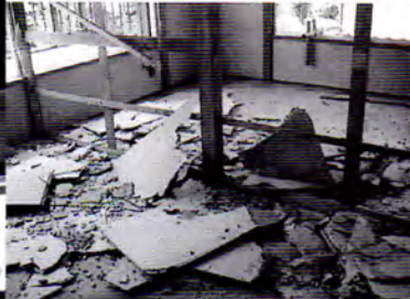
① 建築設備・内装材等の取り外し
