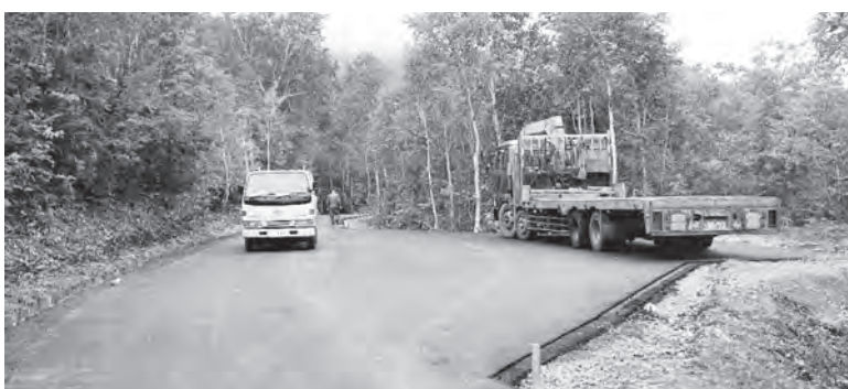
賀老林道舗装工事
