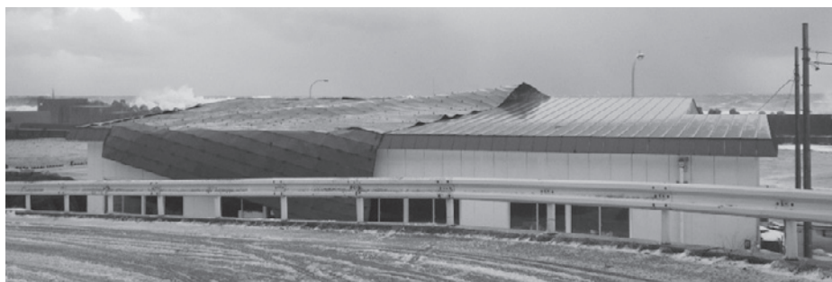
▲軽臼漁港 作業保管施設
