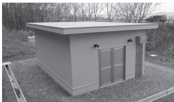
▶ 完成した歌島地区ポンプ室
