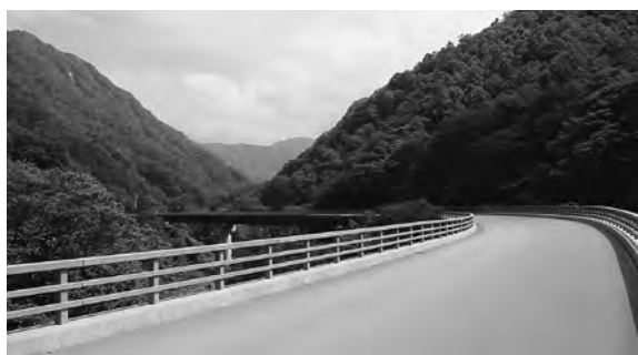
▲通行止めの道道島牧美利河線（ナガセ橋）
