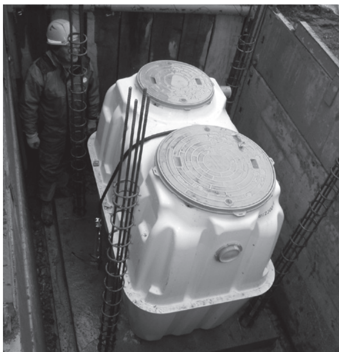
浄化槽設置(本目地区)
