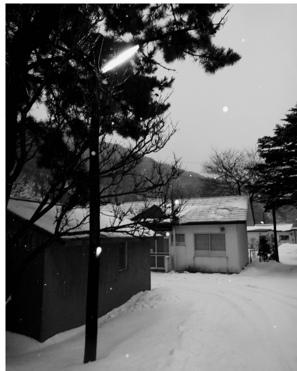
▶現在設置されている蛍光管方式の防犯灯
