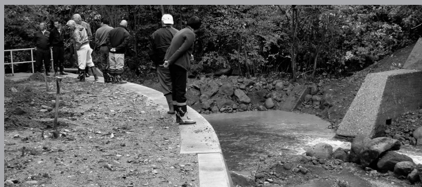
▲九助川治山ダム。サクラマス遡上を容易にするためスリット化(切込み)工事を施工
