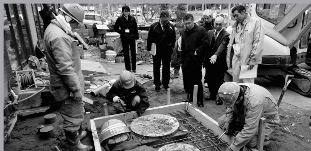
▲合併処理浄化槽の進捗状況を調査
