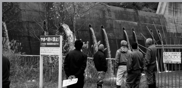
▲河川環境について調査。大平川砂防ダム
