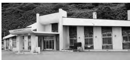
▲避難所に選定されている生活改善センター (標高3.5メートル)
