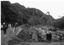
△村道東瀬橋通線災害復旧工事
