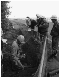
△元町・原地区配水管布設替工事
