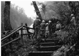
△賀老の滝遊歩道整備工事
