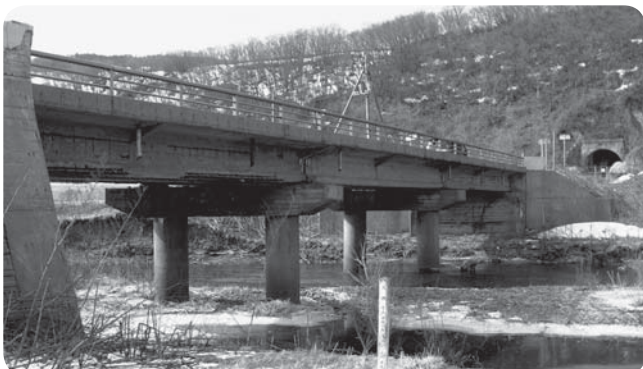
△橋梁点検調査委託（大平川に架かっている村道橋）
