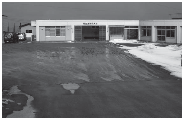
△地域活性化・きめ細かな臨時交付金で計画されている保育所前の舗装工事
