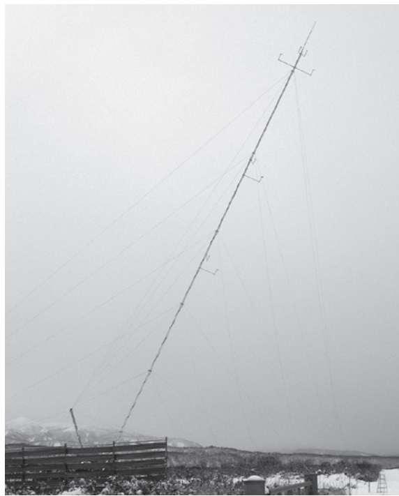
△観測塔の設置作業
