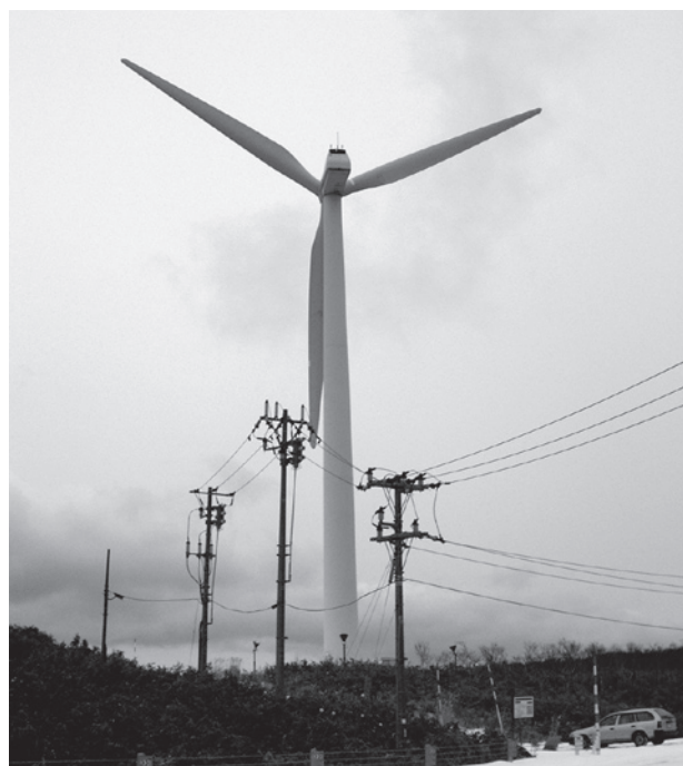
△折損したブレードの交換を終え、運転を再開した3号機
