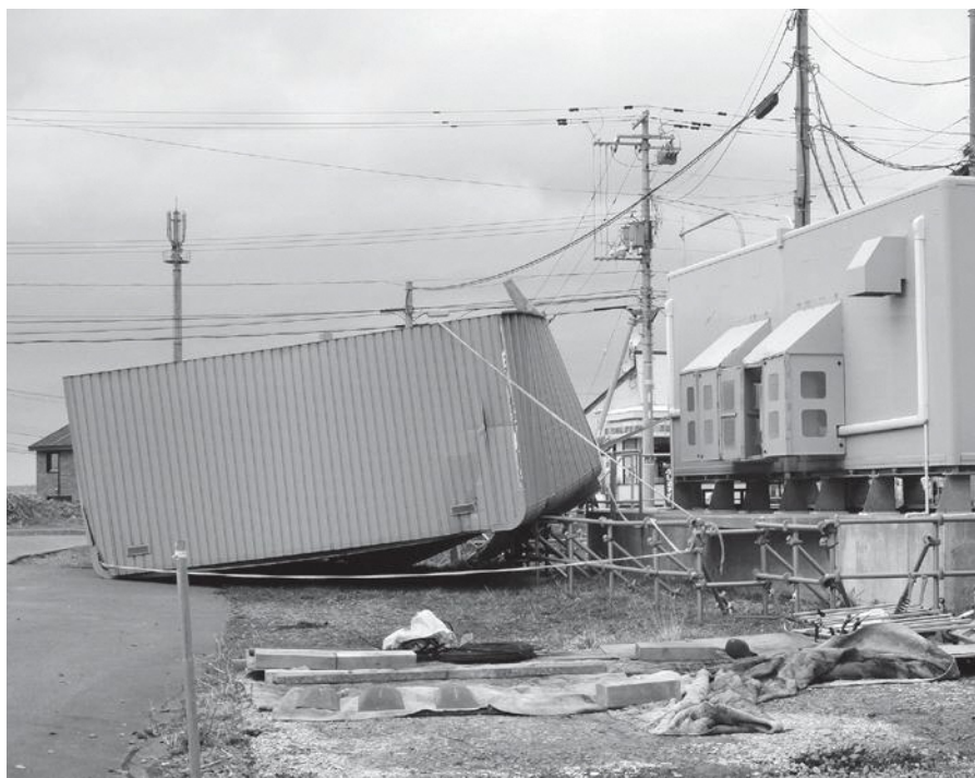
▲倒壊した永豊森林事務所 車庫 — 4月18日 —
