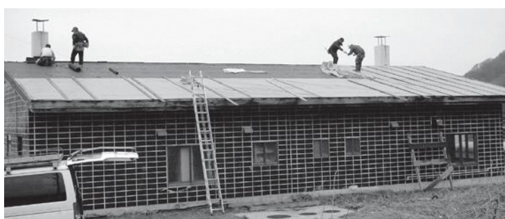
▲屋根トタンが剥離した島牧商工会 — 4月18日 —
