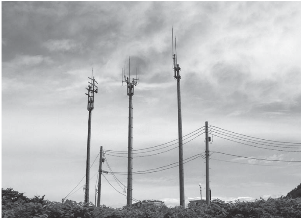
△国の補助を受け平成11年に整備された携帯電話用鉄塔（第二栄浜地区）
