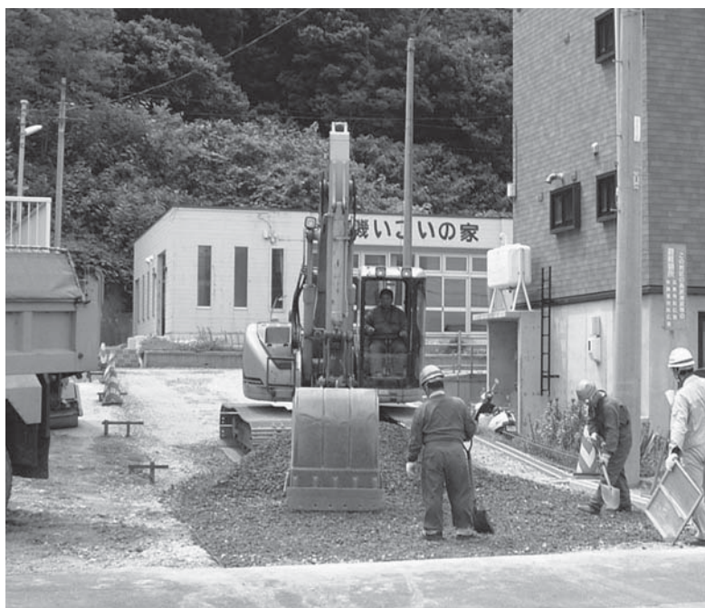
△昨年度からの繰越事業で実施している公共施設前広場等舗装工事(栄磯いこいの家)「地域活性化・生活対策臨時交付金事業」
